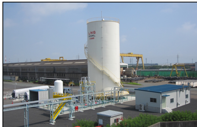
写真：LNGサテライト
