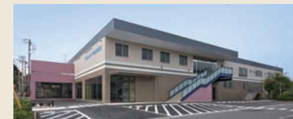
(株)トピーレック「トピレック アヤセ」外観
