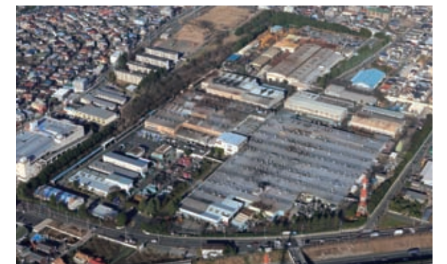
トピー工業(株)綾瀬製造所
