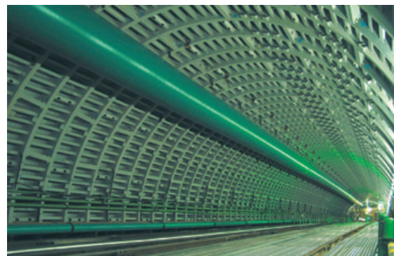
トンネルでの異形形鋼使用例
