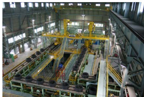
【新設した TACoil®専用ライン】
