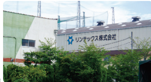
リンテックス株式会社岡山工場外観
