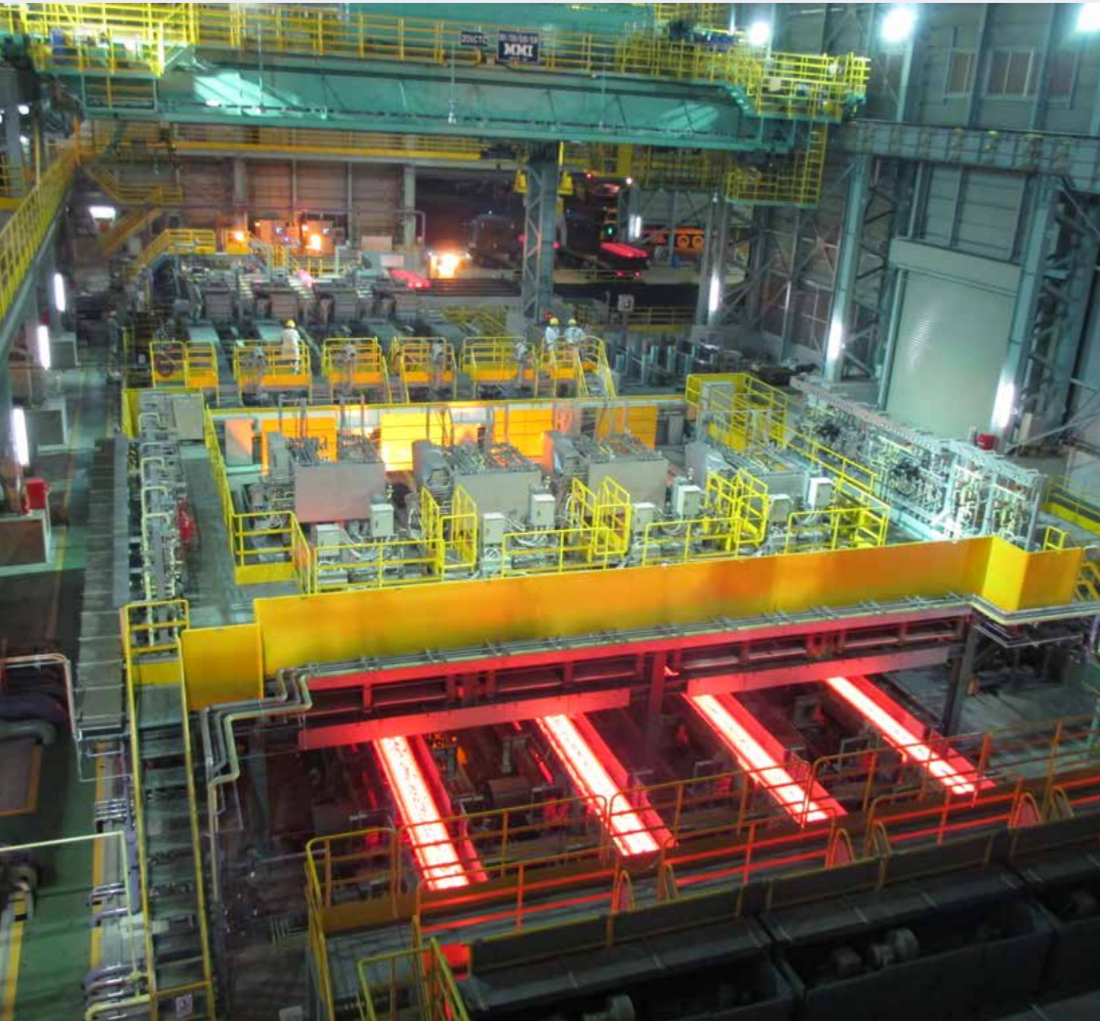
新製鋼工場 連続铸造設備
