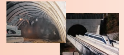
リニア中央新幹線向けのトンネル工事用鋼材
