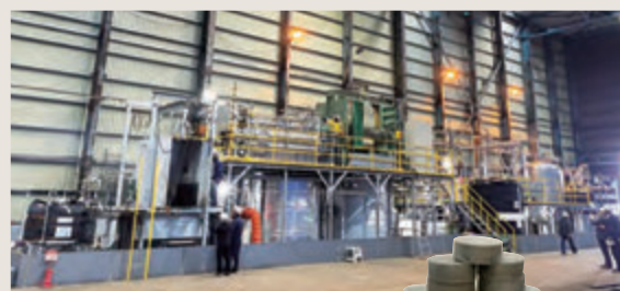
パイロットプラント全景
