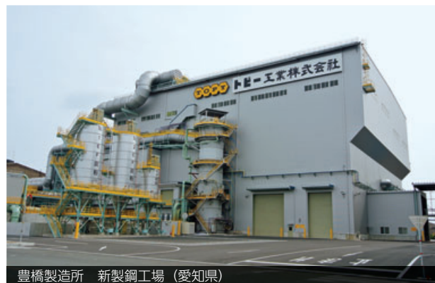
豊橋製造所 新製鋼工場 (愛知県)
